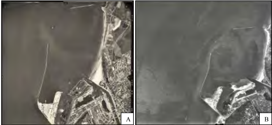
Figure 4 : Images aériennes de la sortie de la rade et du port de Boulogne-sur-Mer lors de la marée montante à HM +2 h (A) et HM -1h (B). (Source : Jouanneau et al., 2013)
